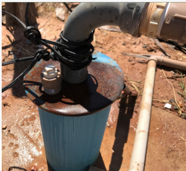
Figura 3: Foto em detalhe do tubo guia instalado.
